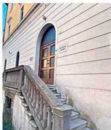
L'ingresso dello Sperti
